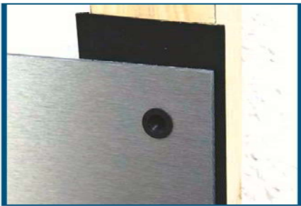
Abb. 11 - Gleitpunkt: Fa-Ze-Di-Ring in Plattenbohrung
