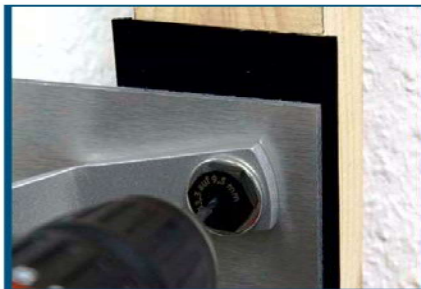
Abb. 9 - Einsatz Bügelbohrvorrichtung, Vorbohren der Holz-UK
